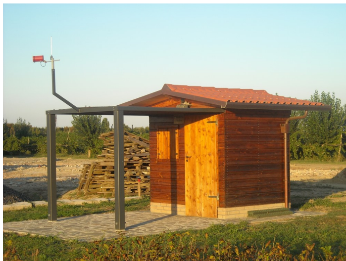
La struttura ultimata così come, sostanzialmente, si presenta ancora oggi.
