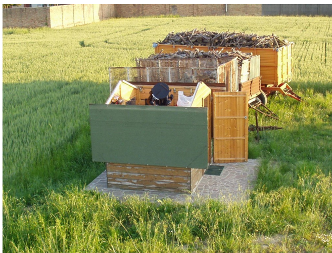
L'osservatorio come si presentava nel 2005 prima della ristrutturazione
